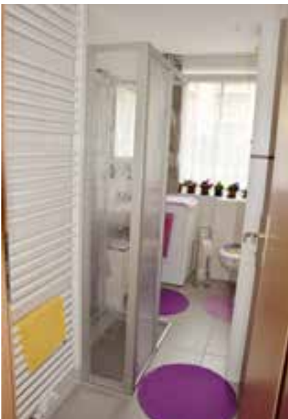
Abbildung 110: Verengung im vorderen Bereich des Badezimmers durch Wandvorsprung und Türblatt. In Ermangelung von Ablageflächen hat die Mieterin ein Regal gestellt, das den Durchgang zwischen Wand und Duschkabine weiter verengt. Sie kann ihren Rollator im Bad nicht benutzen, stützt sich stattdessen an der Wand ab. Duscheinstieg sehr schmal für Pflegeassistentz (Foto: SIBIS Institut).
