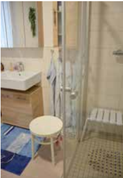
Abbildung 117: Ebenerdige Dusche mit aufklappbarer Duschtrennung mit genügend Platz für pflegebedürftige Person und Assistenz; auch mit Rollator oder Rollstuhl zu passieren (Foto: SIBIS Institut)
