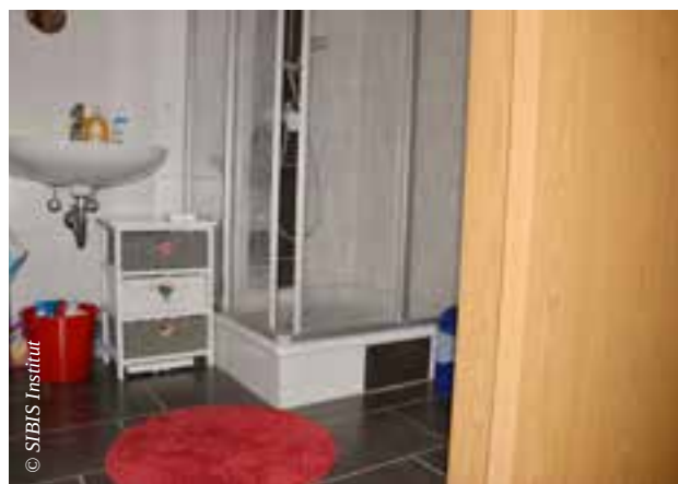
Blick ins Bad: hohe Duschtasse, kleiner Durchmesser der Dusche, im Vordergrund die verbreiterte Tür, hier Schiebetür
