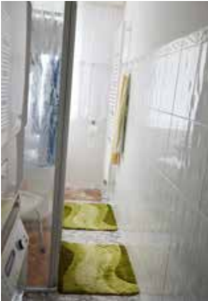
Abbildung 107: Feststehende Duschkabine (Kunststoff) auf festmontiertem Schienensystem verengt den Durchgang zu Toilette und Waschbecken. Durchfahrt mit Rollator nicht möglich; Platz zwischen Waschbecken und Toilette so eng, dass Pflegeassistentz kaum möglich ist (Fotos: SIBIS Institut)
