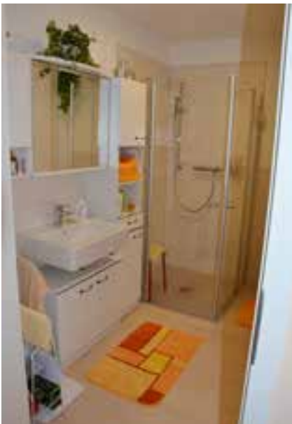
Abbildung 113: Barrierefreie Gestaltung, Tür öffnet nach außen (Sicherheit), ebenerdige Dusche mit wegklappbarem Spritzschutz aus Glas, genügend Platz um die Toilette (Foto: SIBIS Institut)
