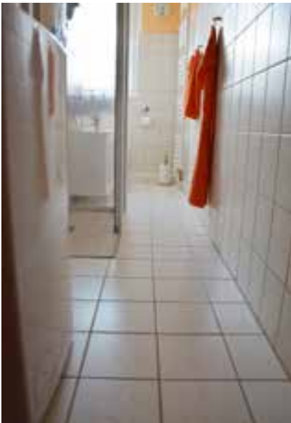
Abbildung 109: Ebenerdige Dusche, wieder mit feststehender Duschkabine, die den Durchgang zu Toilette und Waschbecken auf Fußgänger beschränkt. Keine Haltegriffe (Foto: SIBIS Institut).
