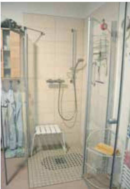
Abbildung 115: Großzügiger Grundriss, ebenerdige Dusche, Spritzschutz aus Glas, geräumig genug für Pflegeunterstützung (Foto: SIBIS Institut)
