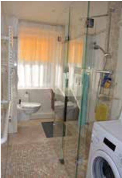
Abbildung 111: Aufwändiger Badumbau, von der Mieterin selbst finanziert. Sie pflegt dort ihren rollstuhlabhängigen Mann. Die beiden Glaswände der Dusche sind vollständig wegklappbar, so dass eine große Duschfläche entsteht, die das Einbringen eines Dusch-Rollstuhls ermöglicht.
