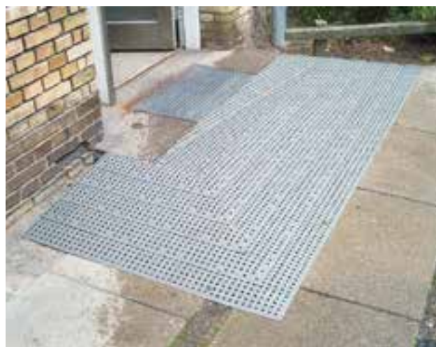
Varianten für Türschwellenrampen, links: Fa. Roeye International, rechts: Excellent Systems A/S
