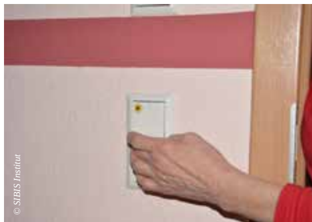
Zurückhaltend, aber deutlich gekennzeichneter Notruftaster im Schlafzimmer der Dreizimmerwohnung
